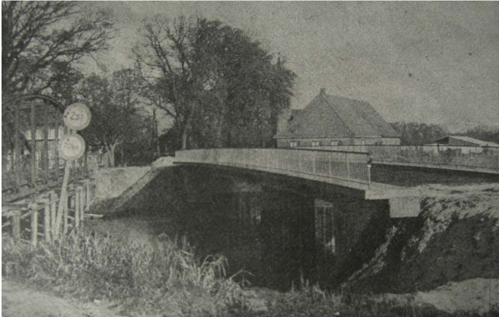
Der neue Vechteübergang im Entstehen – links die alte Bogenbrücke, rechts Haus Laar und reformierte Kirche
