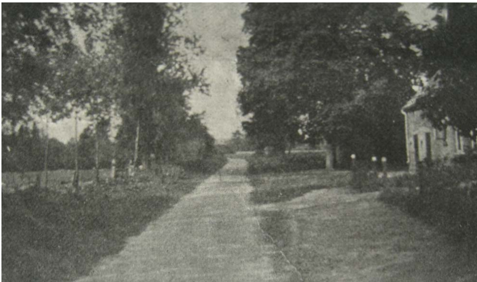
Der Übergang über die Landesgrenze zu den holländischen Nachbarn ist (1974) leider immer noch für den Grenzverkehr tabu.
