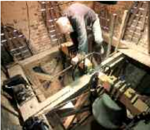
Zwei kleine Elektromotoren setzen die Glocken in Bewegung. Im Hintergrund sind die »Schalllöcher« zu sehen.
