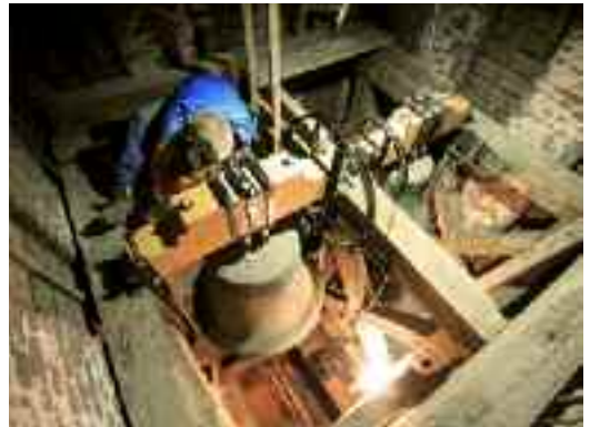
Neue Holzjoche und Läutevorrichtungen wurden im März 2012 montiert. Unter der Glocke ist die letzte Bodentreppe im Turm erkennbar.
