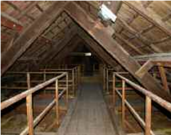
Der Dachstuhl der Kirche im März 2012, wie er vermutlich 1903 erneuert wurde
