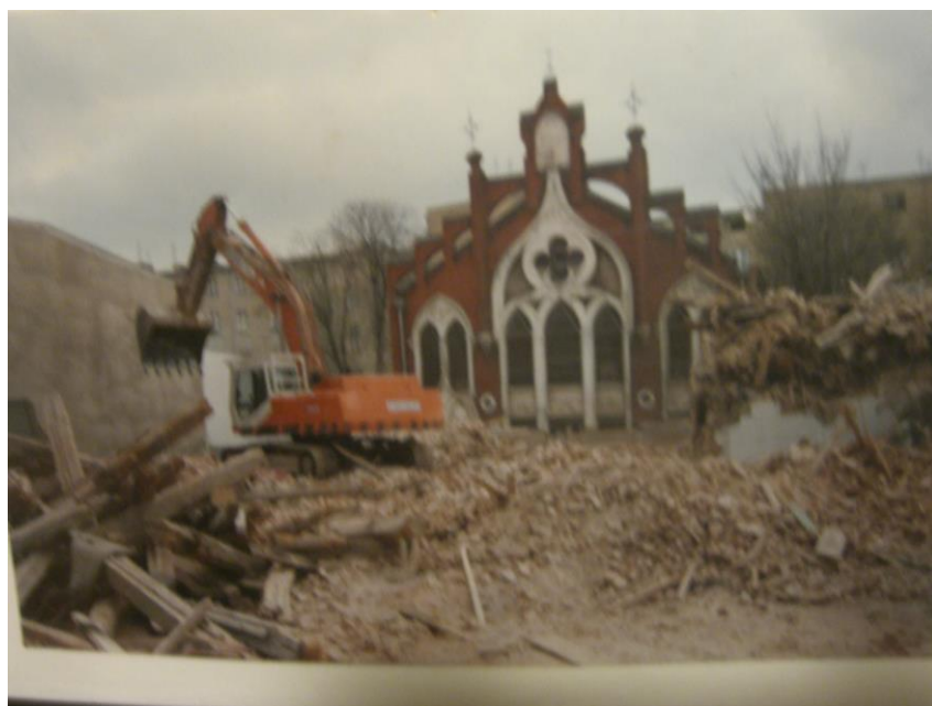
Abbrucharbeiten ca. 1960/70 Foto 2011 in Breslau gjb
