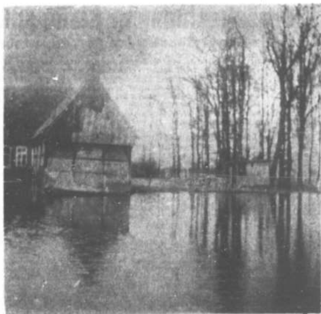
Gefährlich nahe rückte gestern nachmittag das Hochwasser dem Gehöft Strötker in Grasdorf.
