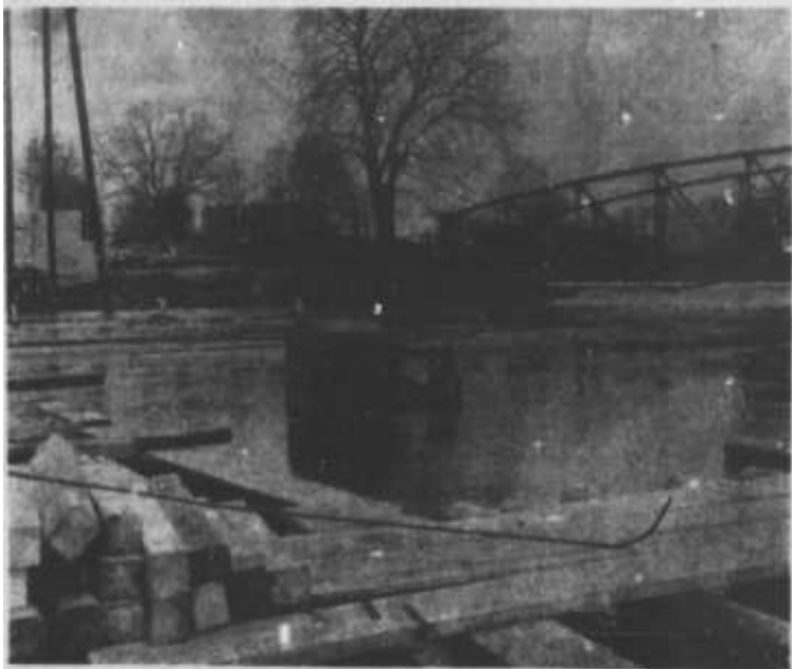
Hochwasser bedroht die Vechthebauarbeiten der Niedergrafschaft! Unsere Aufnahme entstand gestern nachmittag an Richmerings Brücke (im Zuge der Straße Neuen... Veldhausen) in Grasdorf, wo die Vechthe nicht nur anodvoll ist, sondern auch weite Flächen an beiden Seiten der Ufer unter Wasser stehen. Die Brückenbaustelle ist hochstäblich „abgesoffen“. Die Pumpen und die schwere Spunddränne werden von den schmutzig-grauen Wassermassen umspült. Hier wird man einstweilen die Arbeit noch nicht wieder aufnehmen können. Oberdies beweist die Aufnahme, wie sinnlos es sein kann, kurz vor Beginn der „Überschwemmungs-Jahreszeit“ mit derartigen Großprojekten zu beginnen. GN-Foto: -wf-
