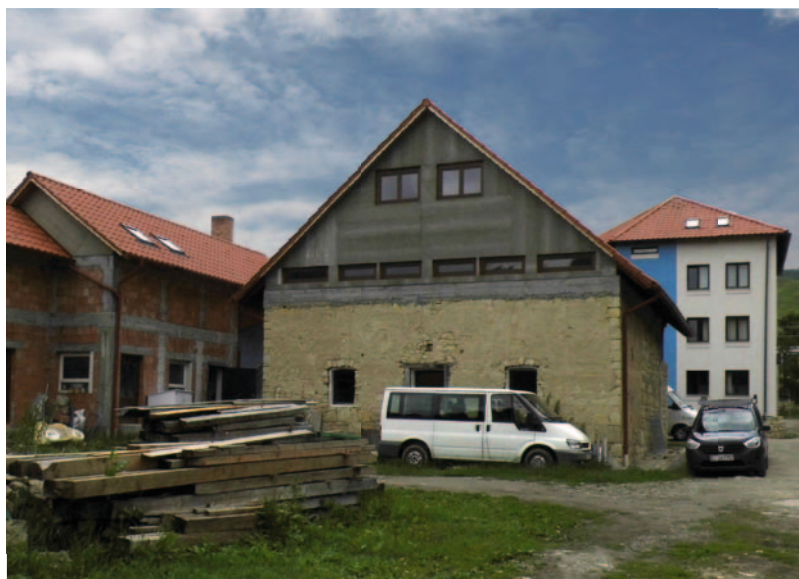
Hinter dem Altenheim entsteht eine Unterkunft für das Kinderprojekt. Schritt für Schritt schreiten dort die Bauarbeiten voran.
