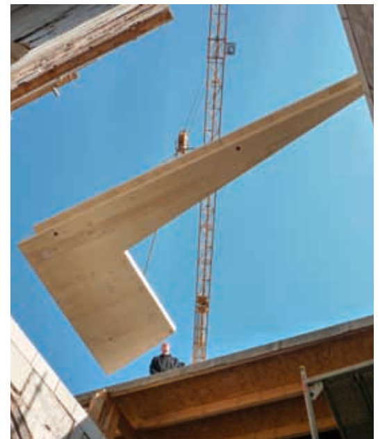
Noch bevor die Decke geschlossen werden konnte, musste die Orgelempore eingebaut sein. Sieben vorgefertigte Teile wurden mit viel Fingerspitzengefühl in die Kirche gehoben, auf den eingemauerten Polstern abgesetzt und miteinander verschraubt.
